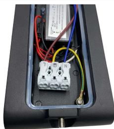
**7.** Faça as conexões elétricas no conector conectando os fios correspondentes.
