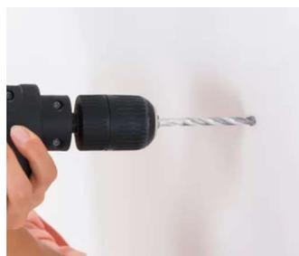
**5.** Faça os furos na parede nos pontos previamente marcados e coloque as buchas.
